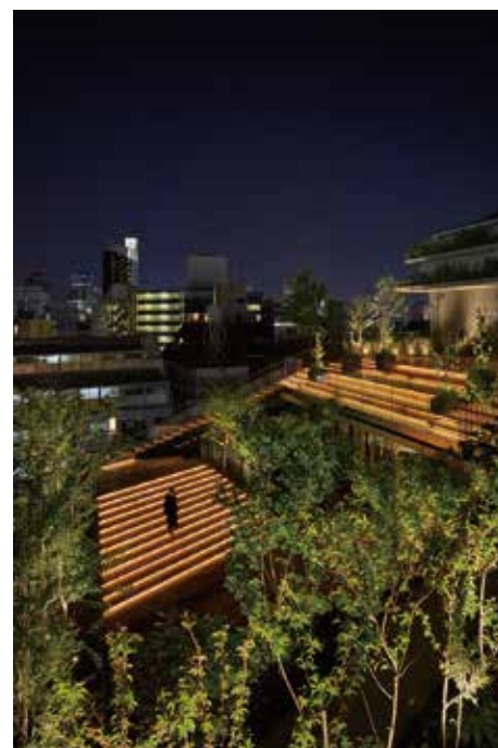
ウイズ原宿 設計：株式会社竹中工務店+伊東豊雄建築設計事務所 施工：株式会社竹中工務店 照明デザイン：有限会社シリウスライティングオフィス 撮影：鈴木文人
